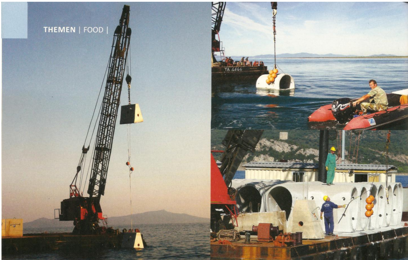
Als „schlafende Agenten“ lauern die massiven Betonblöcke mit ihren Eisenhaken auf die illegalen Schleppnetzfischer. Die Betonröhren daneben dienen als „Fischhäuser“. Sie bieten einen Platz zum Laichen und als Schutz für die junge Fischbrut.
